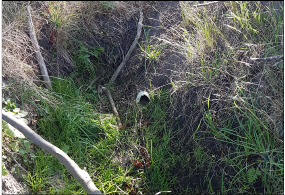
Figur 5: Drænudløb til grøft, der med tilløb til det primære vandløb i st. 410 m.
